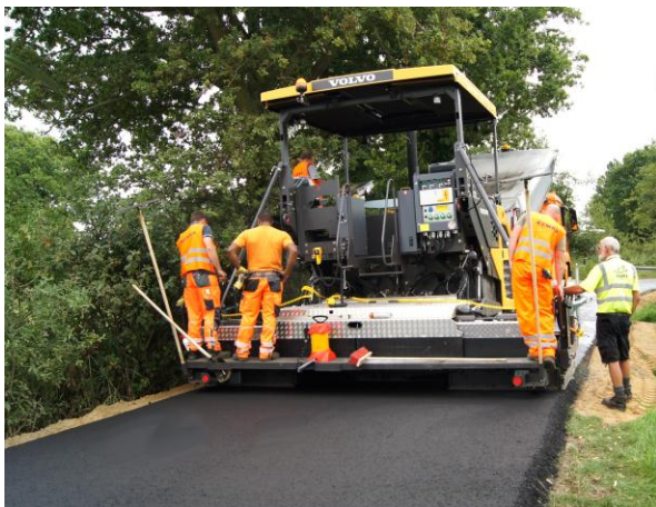
Asphaltierung des Potsdamer Weges mit dem neuen Volvo Fertiger
