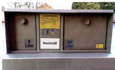
Benutzung mittels RFID-Chip: Über den Chip wird der Nutzer identifiziert, die Müllschleuse wird geöffnet, der Nutzer kann seinen Müll einwerfen
