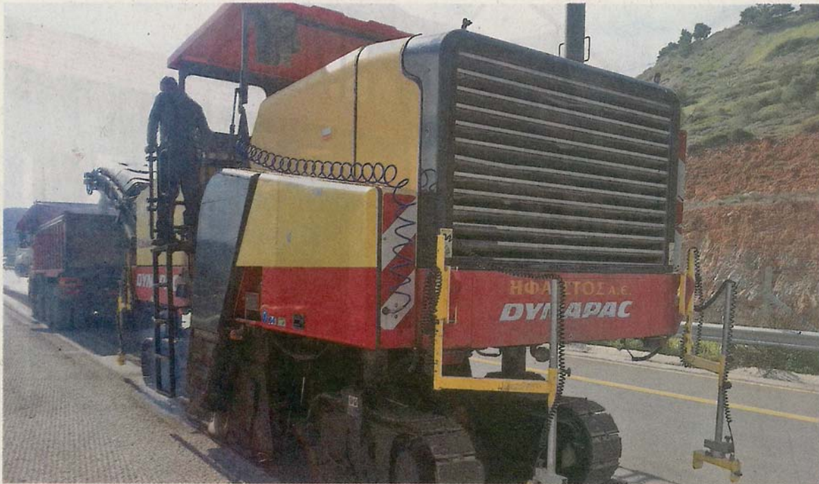
Big Sonic-Ski Installation an der Fräse.
